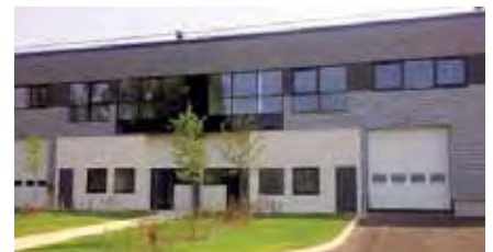
12 Parc Jean Mermoz, 53 rue de Verdun – 81, rue Maurice Berteaux, La Courneuve
