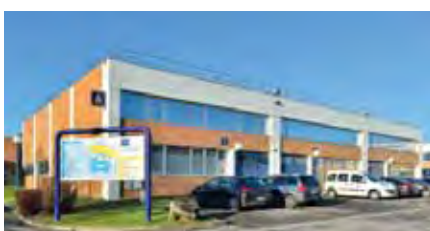
16 Parc de Champs, 40 boulevard de Nesles, ZAC le Ru du Nesles, Champs sur Marne
