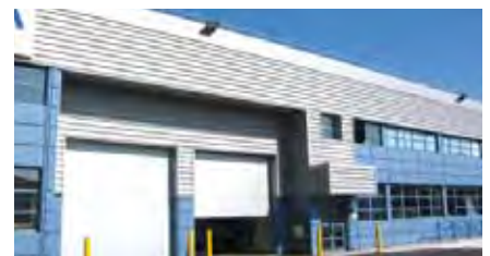
9 Parc Urbaparc, 75-79 rue du Rateau, La Courneuve
