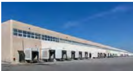
13 Strada Provinciale Adelfia, Rutigliano
