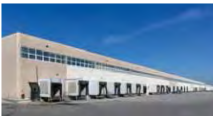
14 Strada Provinciale Adelfia, Rutigliano
