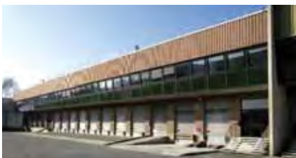
16 Parc Locaparc 2, Vitry-sur-Seine
