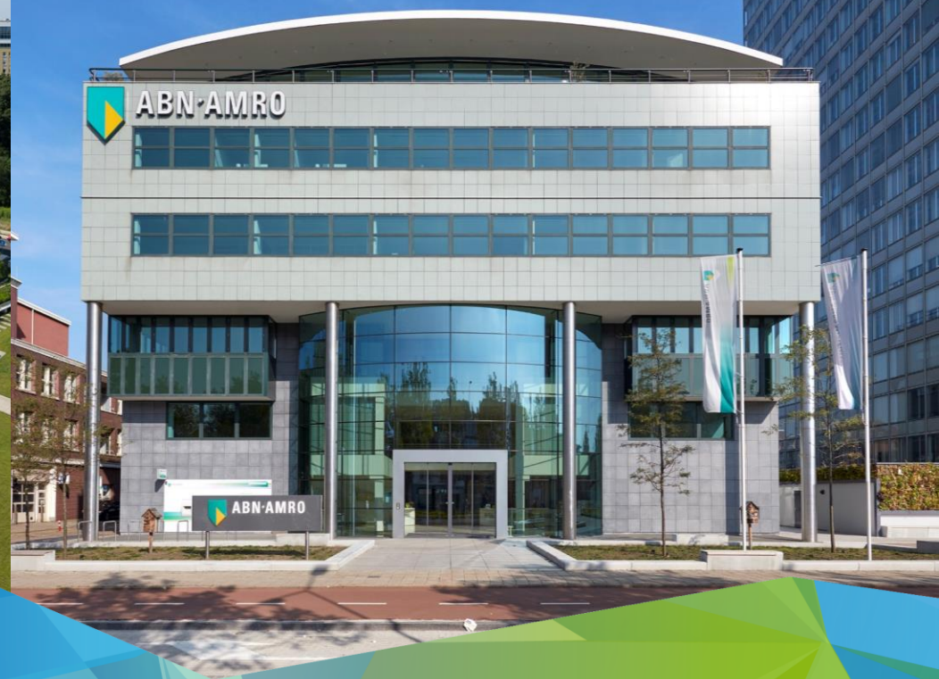
Koningskade 30 Den Haag, The Netherlands
