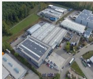
Göppinger Straße 1 – 3 Pforzheim, Germany
