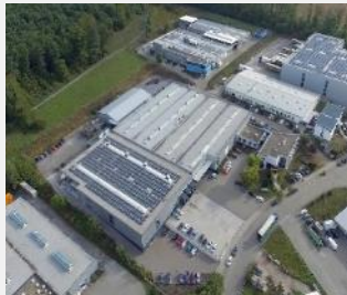
Göppinger Straße 1 – 3 Pforzheim, Germany
