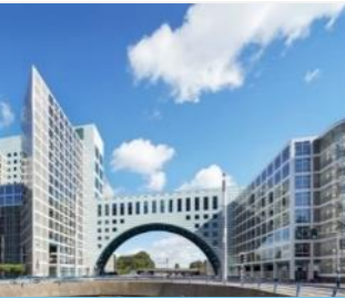
Haagse Poort Den Haag, The Netherlands
