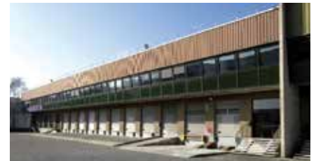
12 Parc Locaparc 2, Vitry-sur-Seine
