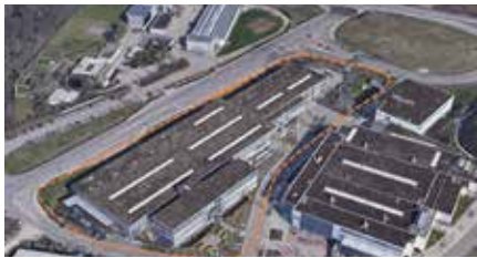
4 Göppinger Straße 1 – 3, Pforzheim
