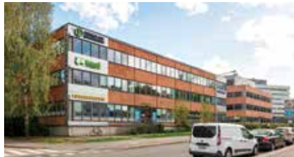
8 Mäkitorpantie 3b, Helsinki
