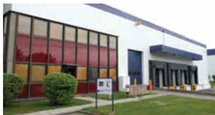
17 Parc du Bois du Tambour, Route de Nancy, Gondreville
