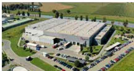
1 Moravia Industrial Park, Uherské Hradiště
