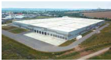
2 An der Wasserschluft 7, Sangerhausen
