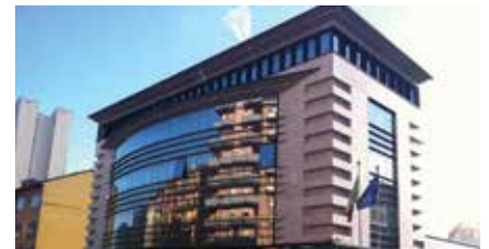
15 Via Rampa Cavalcavia 16-18, Venice Mestre
