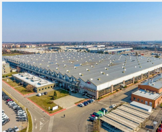
ABB Industrial Site Vittuone, Milan, Italy ("ABB")
