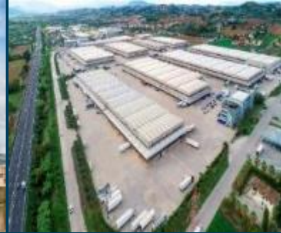
Centro Logistico Orlando Marconi (CLOM)
