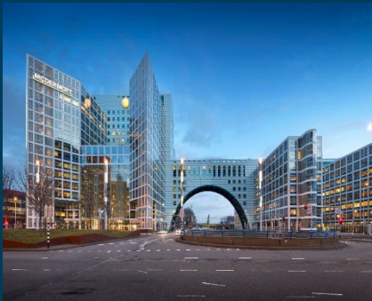
Haagse Poort Den Haag, The Netherlands
