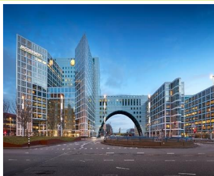
Haagse Poort Den Haag, The Netherlands
