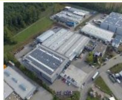
Göppinger Straße 1 – 3 Pforzheim, Germany
