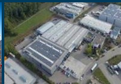
Göppinger Straße 1 - 3 Pforzheim, Germany
