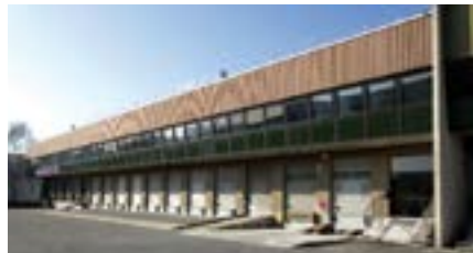
11 Parc Locaparc 2, Vitry-sur-Seine
