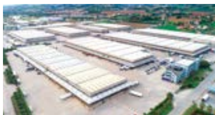
1 CLOM (Centro Logistico Orlando Marconi), Via del Lavoro, Monteprandone
