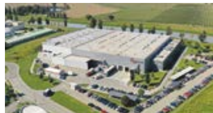
3 Moravia Industrial Park, Uherské Hradiště
